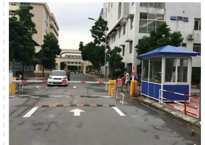
Bệnh viện Đa khoa Bắc Ninh
