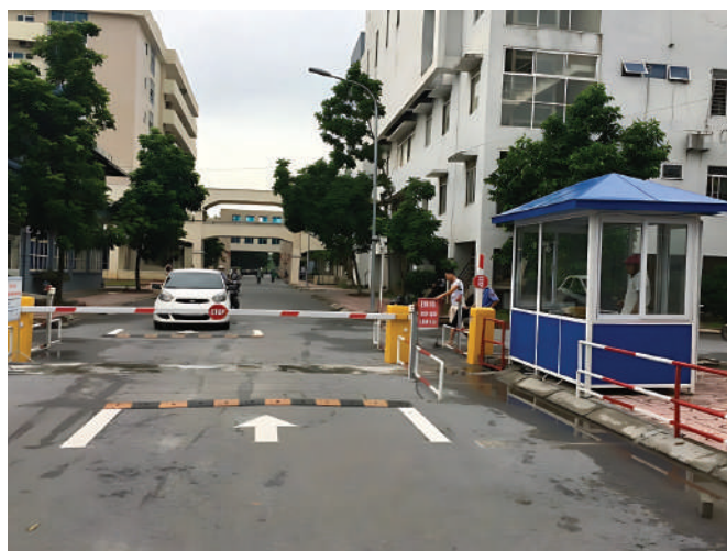
Bệnh viện Đa khoa Bắc Ninh
